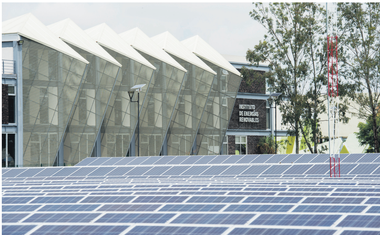
El huerto solar de CUTonalá cuenta con mil 560 paneles fotovoltaicos. / FOTO: DAVID VALDOVINOS
