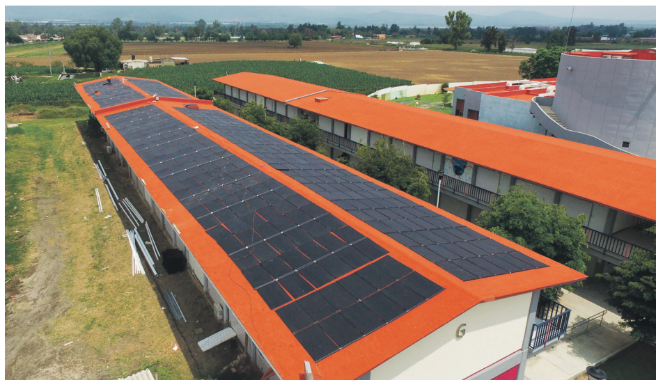
Se instalaron 128 paneles solares en la azotea del Centro Acuático y del edificio F. / FOTO: CORTESÍA
