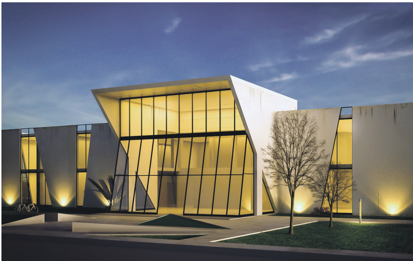
El edificio del CReCE en CUTonalá tiene un avance en su construcción del 95 por ciento. / FOTO: CORTESÍA
