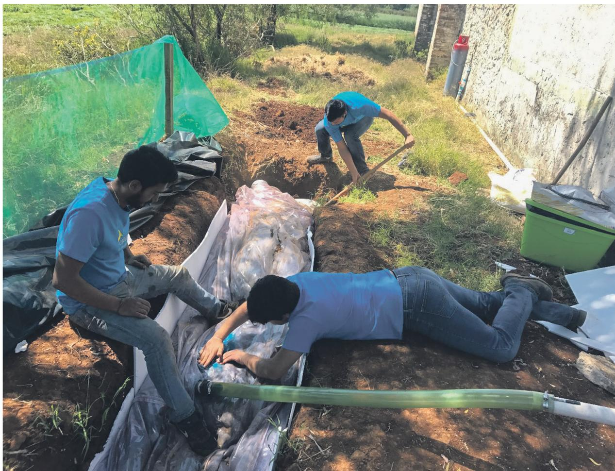
El biodigestor se entierra parcialmente y al centro se le conecta una manguera que lleva el gas a los puntos de consumo. / FOTO: CORTESÍA
