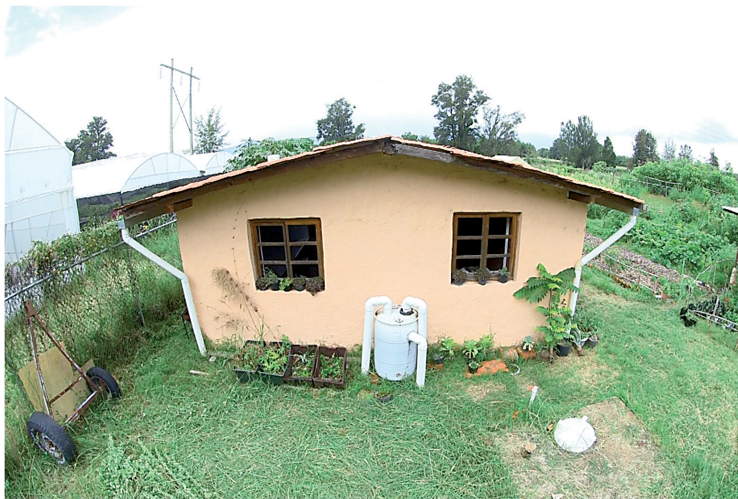
La “Casa de Paja” del CUCBA cuenta con sistema de captación de agua de lluvia. / FOTOGRAMA: SERGIO GUZMÁN
