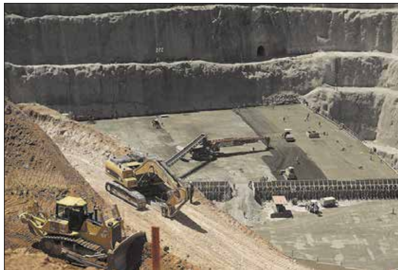
▲ Construcción de la Presa El Zapotillo. Foto: Archivo
