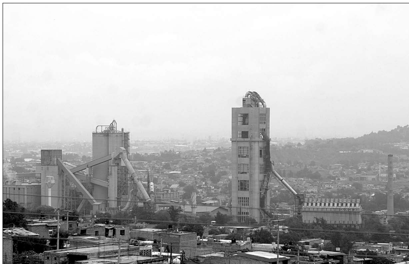
▲ Zona industrial en Guadalajara. Muchos de los desechos son tirados a la Red de alcantarillado público. Foto: Abel Hernández
