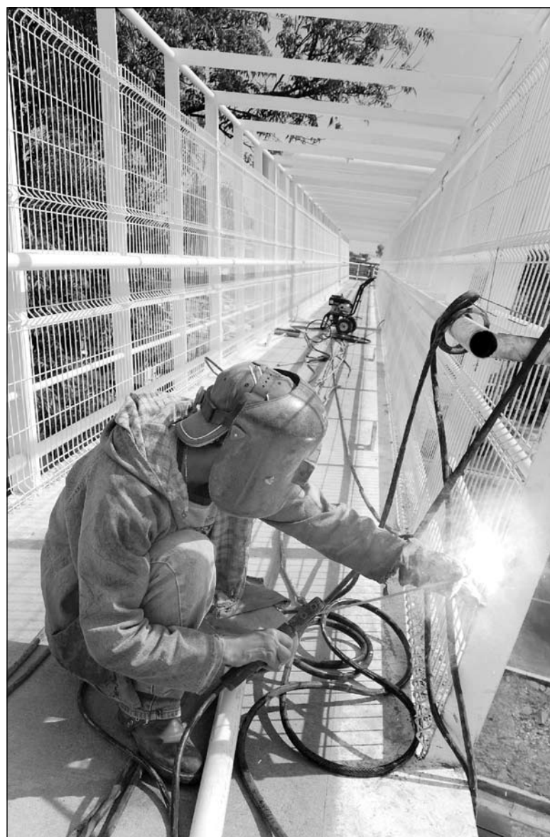
▲ Construcción exprés de un puente peatonal, en el “viaducto” de López Mateos. Foto: Giorgio Viera
