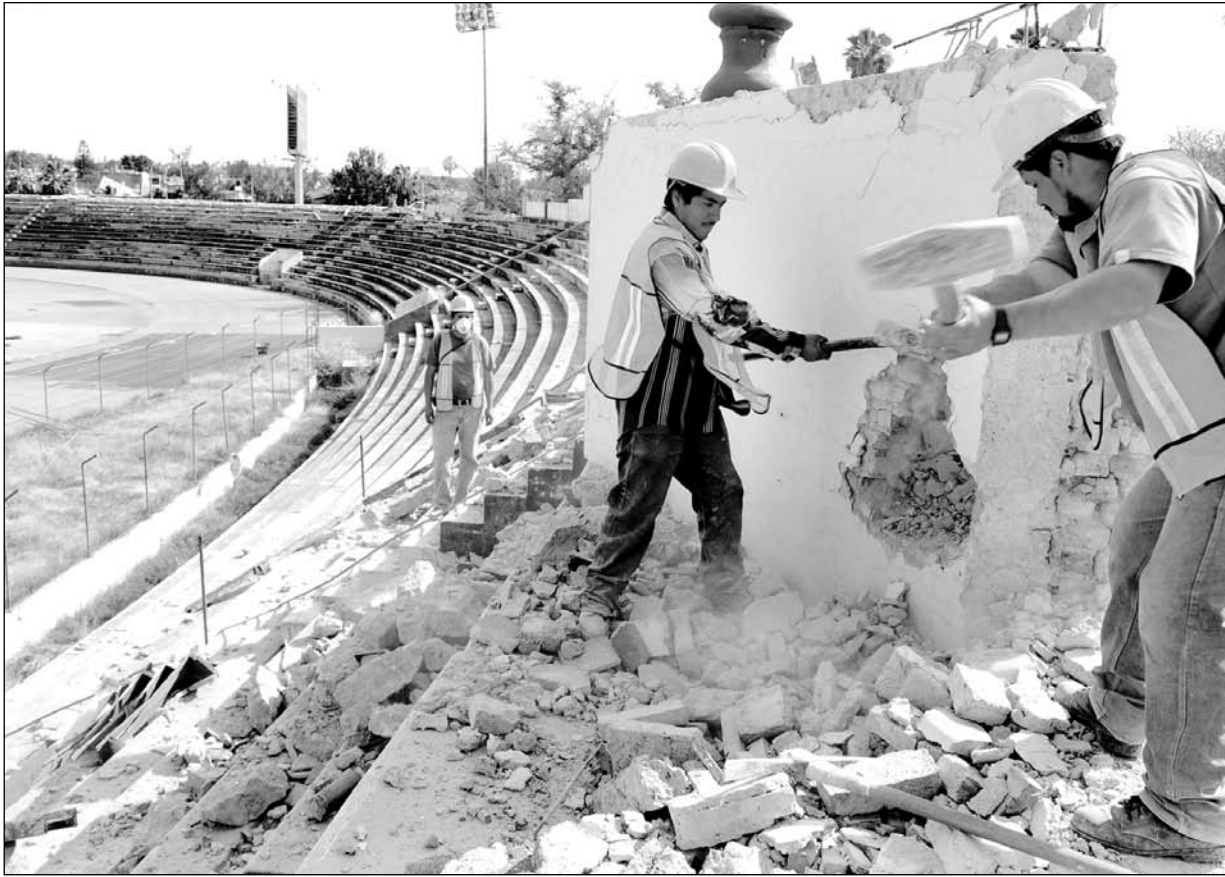
◄ Dos hombres trabajan en la demolición del estadio Tecnológico. Foto: Giorgio Viera
