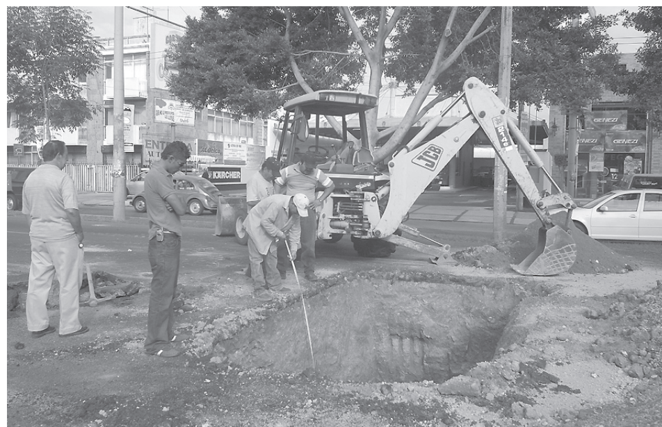
Primeros trabajos en la avenida de Las Rosas
