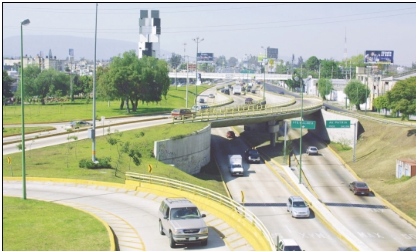
A unos años de la construcción del nodo vial Los cubos, especialistas detectan problemas, como contaminación y choques
