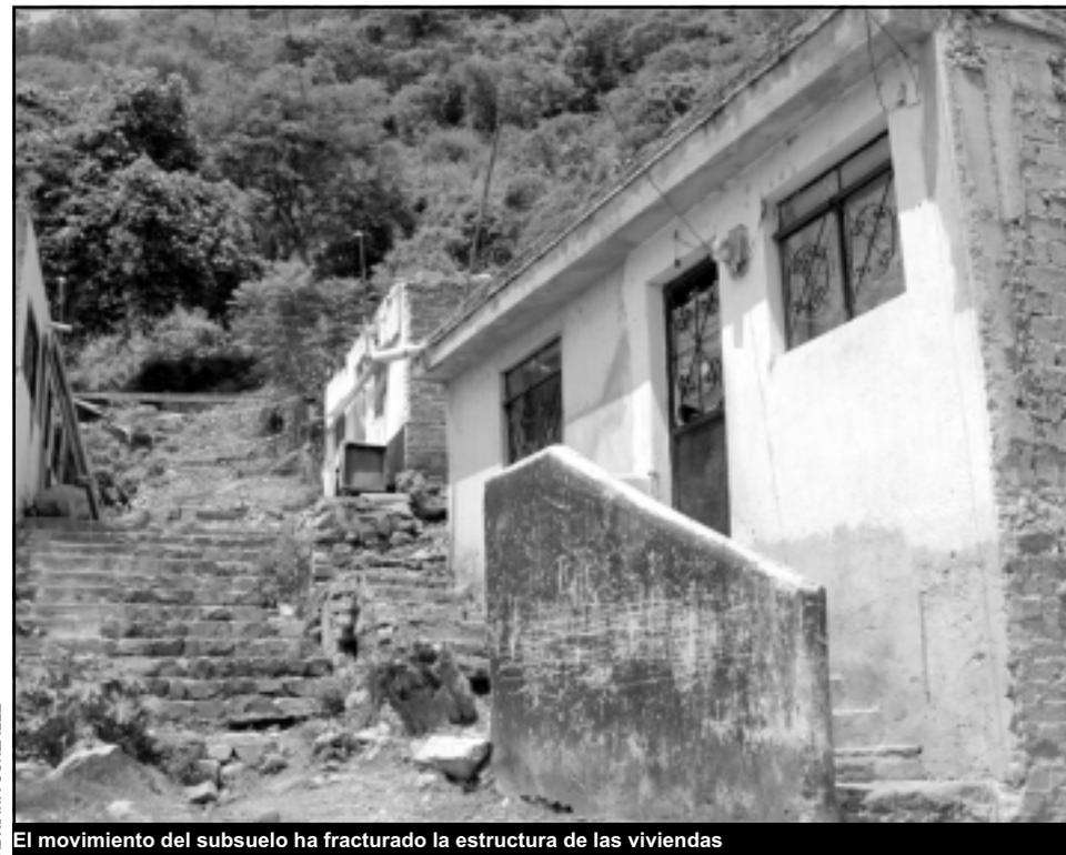
El movimiento del subsuelo ha fracturado la estructura de las viviendas
