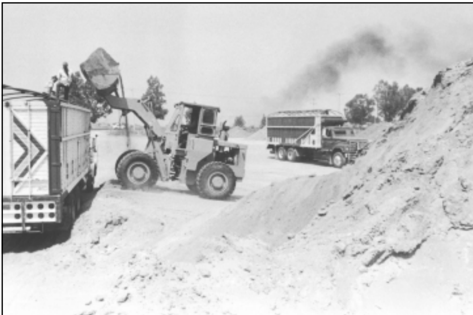
Existen cerca de 2 mil bancos de material abandonados en la zona conurbada
